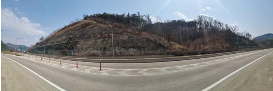
영천절토 33 (관리이정 0.360~0.690km / 5공구 군위R-A(본선)STA.0+360~0+690
