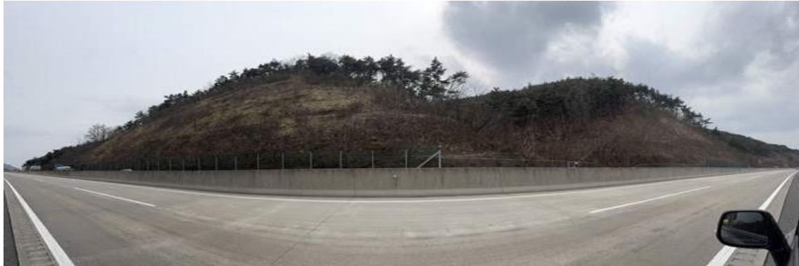
영천절토 39 (관리이정 55.188~55.448km / 6공구 STA.10+970~11+230)
