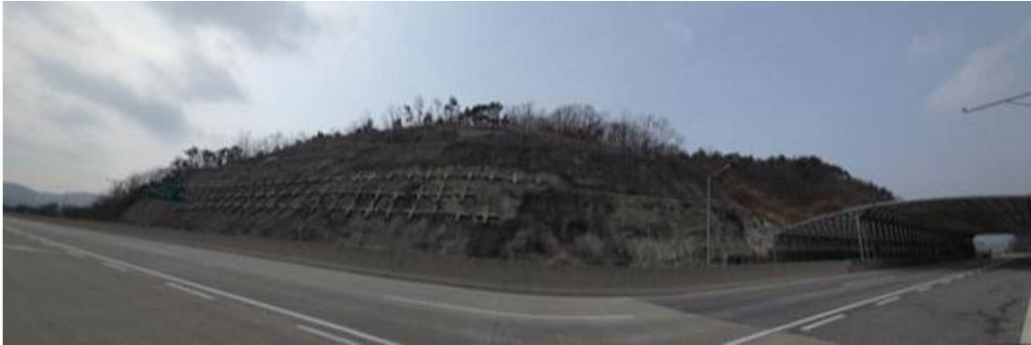
영천절토 23 (관리이정 27.674~28.114km / 3공구 STA.11+660~12+100)
